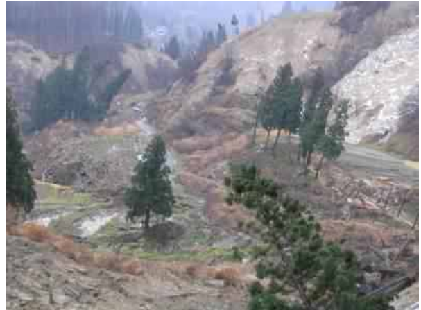
図 7 池谷の地すべり。写真中央右の右に傾いた杉の載る地盤から左端の傾いた杉の載る地盤までが左に側方移動している。右に高い滑落崖がある。中央と左側には圧縮による皺が形成されている。
