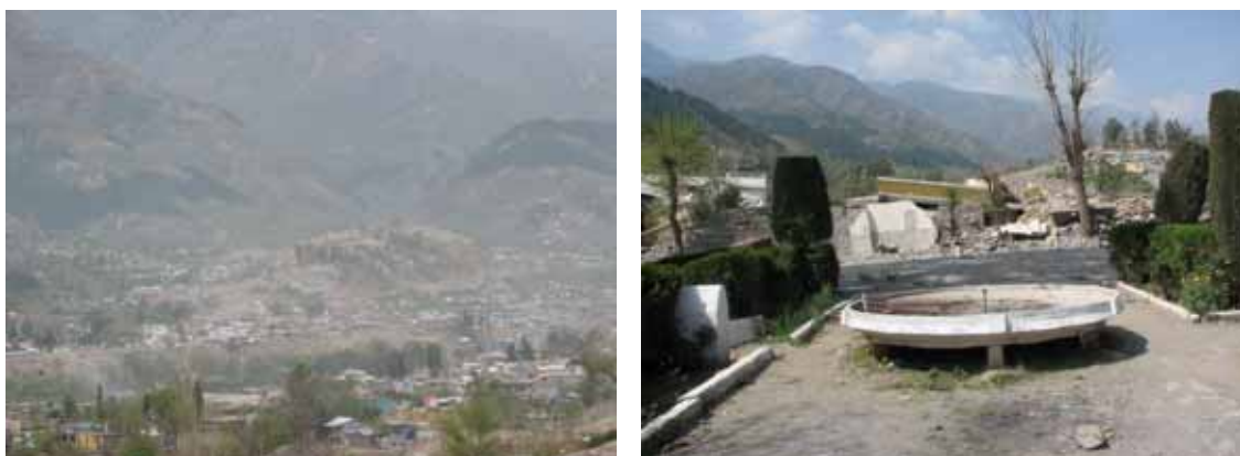
図 4 バラコットの地震断層直上の被災状況。左は前景で、中央の左に傾斜する丘の上にあった中心街は全滅した。その左裾を右奥から左手前に地震断層が通過している。右はこの丘陵を手前から見たところで、写真中央奥から左手前に地震断層が通過している。地震断層の出現に伴って手前の噴水盤は左に約 4 度傾斜した。
