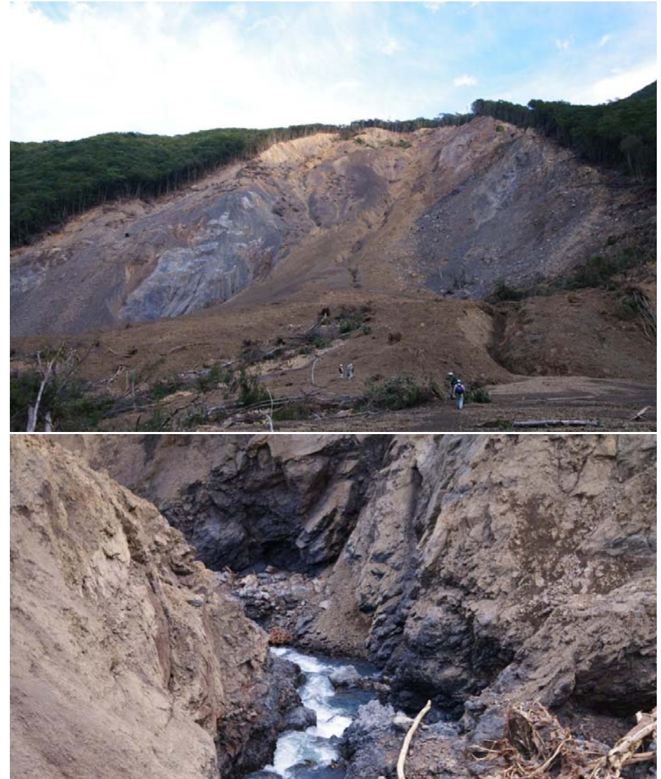
下刻された天然ダム内には10m以上の大岩塊がある。ここは本来砂岩が分布しているところ。土砂ダムとは言え、内部には大岩塊が多いと想定される。→少なくとも全体が崩れ落ちることはない。
