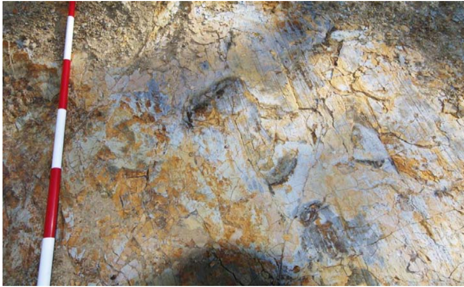
泥岩の層理面についた条線(今回の滑りによる)
