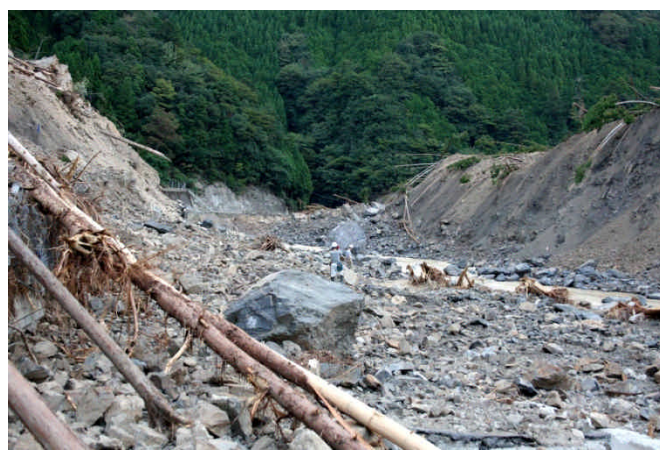
下流から見た土砂ダムの開削状況
