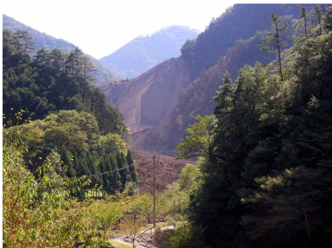
中津川左岸から見た土砂ダム(赤谷地区)
