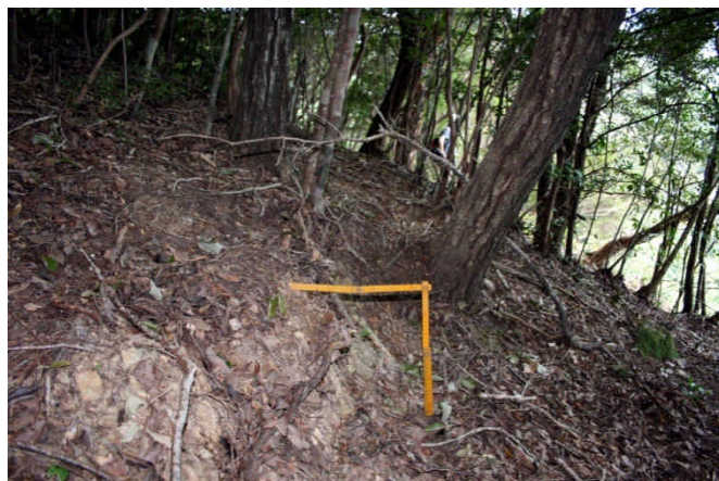
頭部滑落崖の後背斜面の状況
