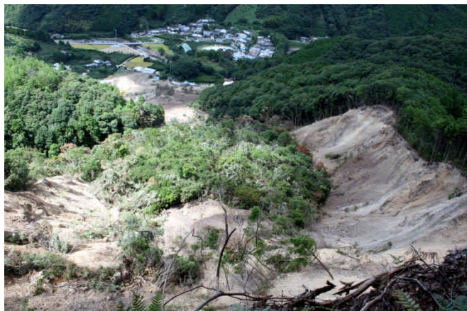
頭部滑落崖から見た崩壊地全景
