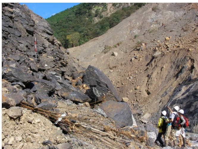
崩落した岩塊に認められた重力変形 (赤谷東地区)
